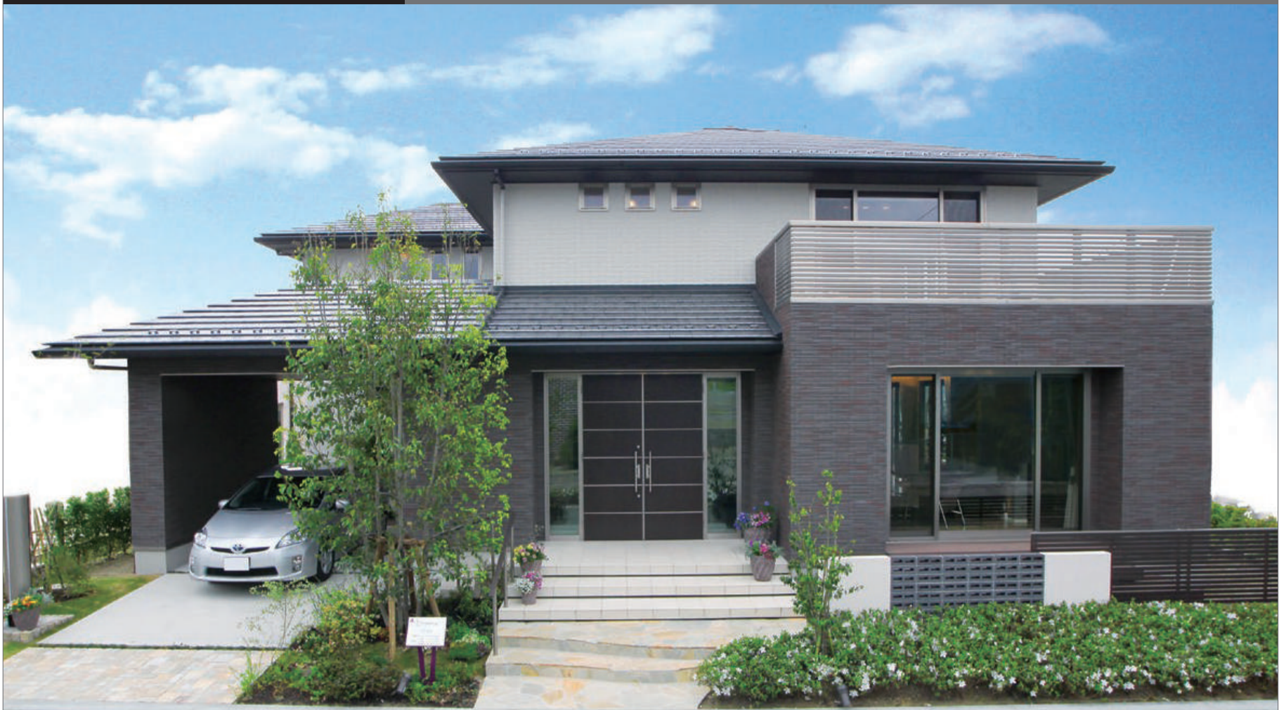
泉ハウジングパーク紫山展示場 最先端の技術の数々もさることながら、長寿命化と時代に合わせた可変性の両立を実現している点も大きなポイントだ。
