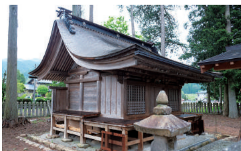
荒城神社(国指定重要文化財) 神社の創建は古く本殿は室町初期の三間社流造り、柿板葺き。1390年に再建され現在の姿へ。毎年9月7日の例祭には、神事鉦打・獅子舞(県指定重要無形文化財)が奉納される。
