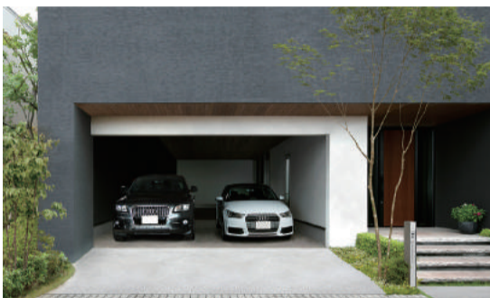
間柱や壁がない開口部はビッグフレーム構法ならではの、耐震性を確保しながら、ビルドインガレージを設けることができる。
