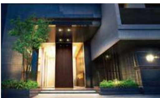
天然石を贅沢にあしらい、高さ4.8mの吹き抜けのびやかな開放感を演出するエントランス。重厚感あふれる扉は私邸としての堂々たる風格だ。
