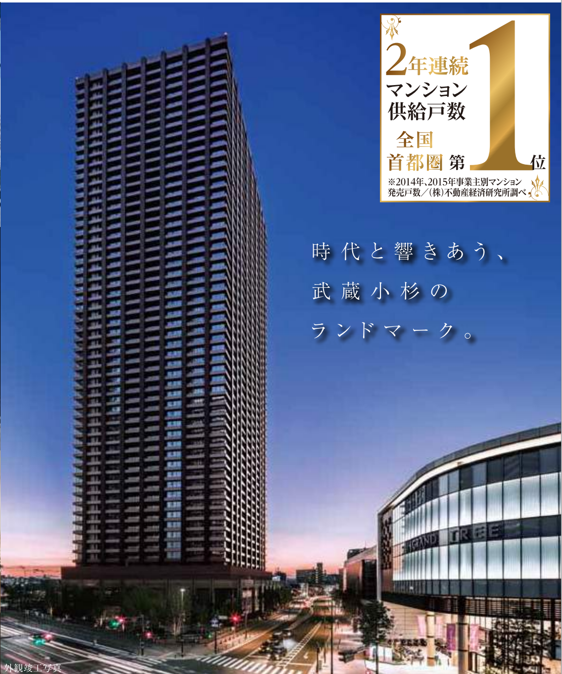
外観竣工写真
