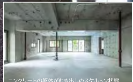
コンクリートの躯体がむき出しのスケルトン状態
