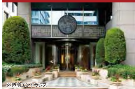
外苑前エントランス
