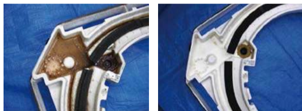
グリルやフィルターに目が行きがちなエアコンだが、カビなどの温床となりやすい結露の水の受け皿「ドレンパン」も取り外してしっかり洗浄。
